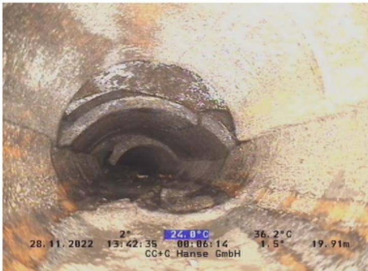
Abbildung 3: Rohrbruch ohne fehlende Teile, Abbruch der Inspektion
