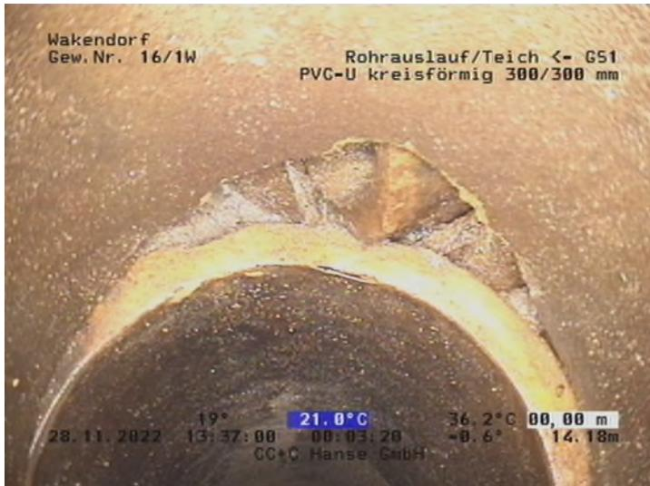
Abbildung 2: Anschluss DN 100 bei 12 Uhr
